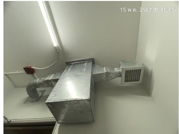
พัดลมดูดอากาศในห้องพักขยะ
