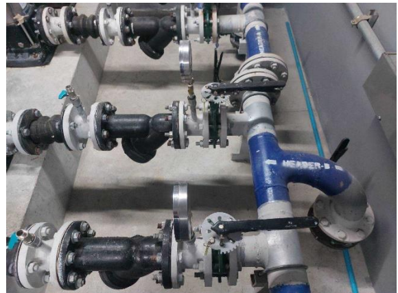
การตรวจสอบเส้นท่อประปา ภาพที่ 2-5 ระบบน้ำใช้ของโครงการ
