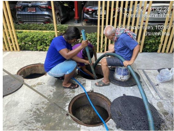
การดูตะกอนของระบบบำบัดน้ำเสีย
