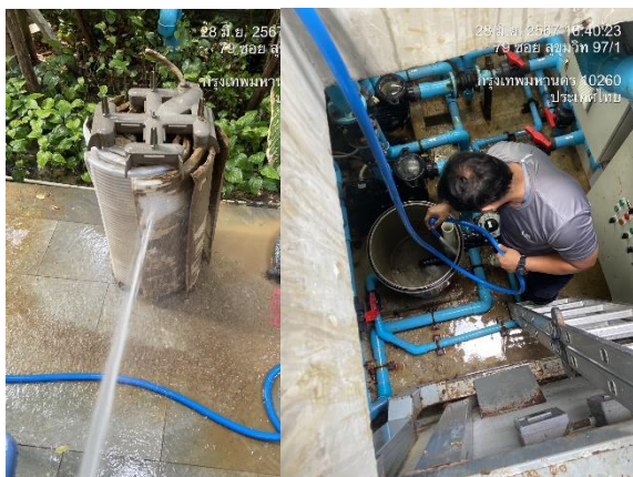
การล้างเครื่องกรองน้ำสรวายน้ำ
